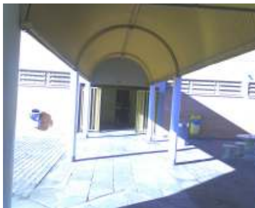
Acesso ao prédio
