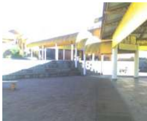
Escadas que impedem o acesso de Pnees ao prédio
